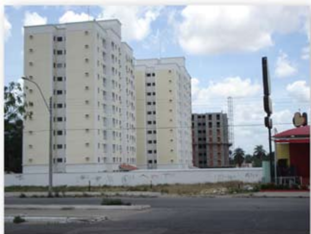
Torre San Matteo, a frente, entregue Torre San Marco, ao centro, em fase final de acabamento Torre San Luca, com 50% de execução
